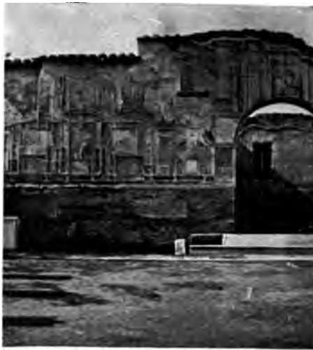
141. Südwestliche Mauer der Stabianer Thermen zu Pompeji.
